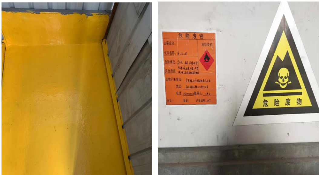
图4-3 危险固体废物暂存间
