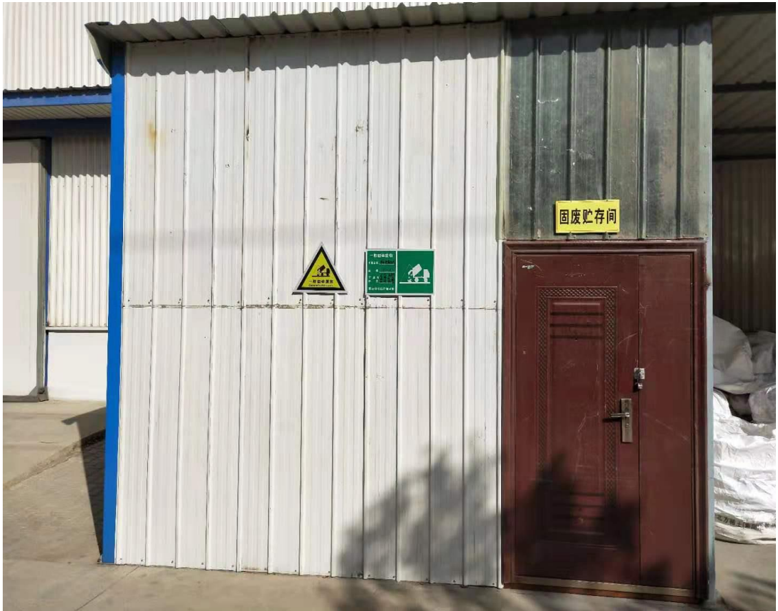
图4-2 一般固体废物暂存间
