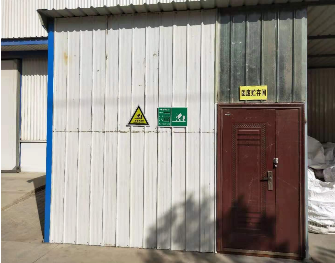
图4-2 一般固体废物暂存间
