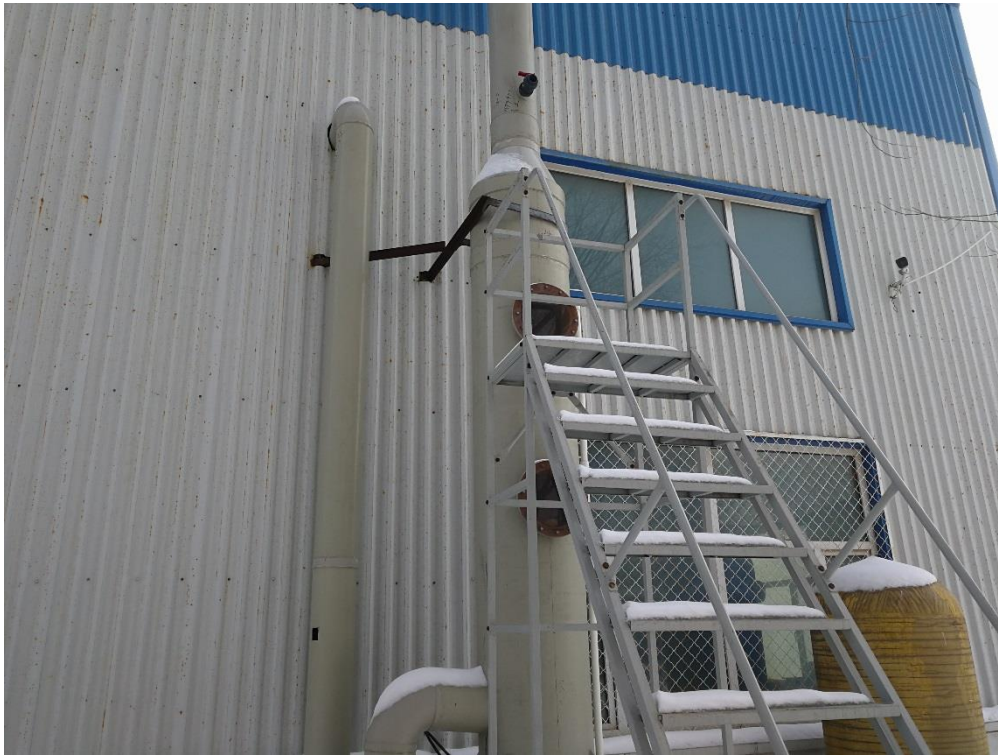
图4-3 废气排放口监测平台
